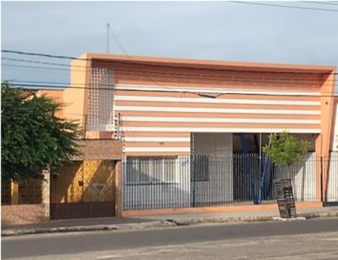
Figura 6: Edificação modernista demolida em Pau dos Ferros - RN
