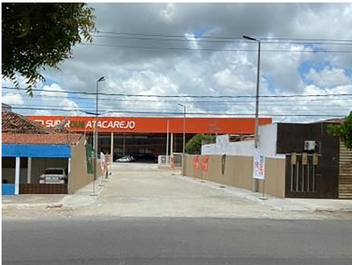
Figura 7: Via de acesso criada após demolição da edificação apresentada anteriormente
