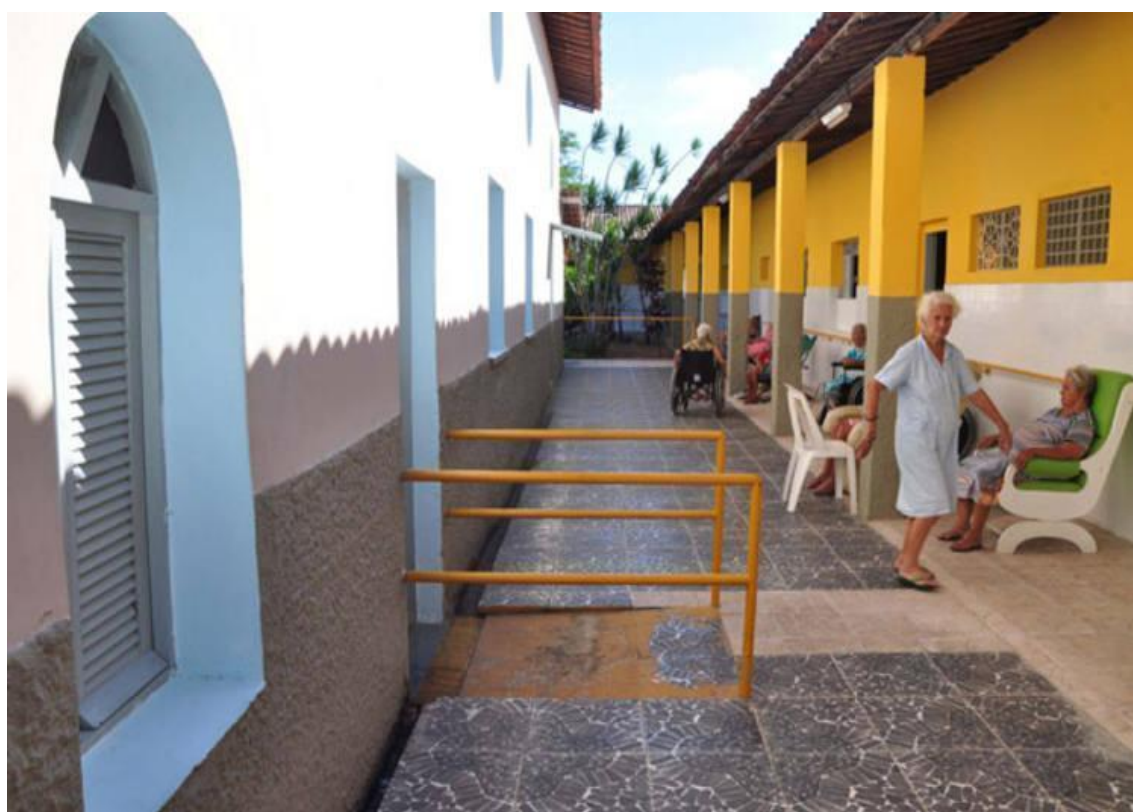
Figura 2 - Pátio de Lazer onde "residentes" costumam passar a maior parte do dia – Fonte: Site Tribuna do Norte.
