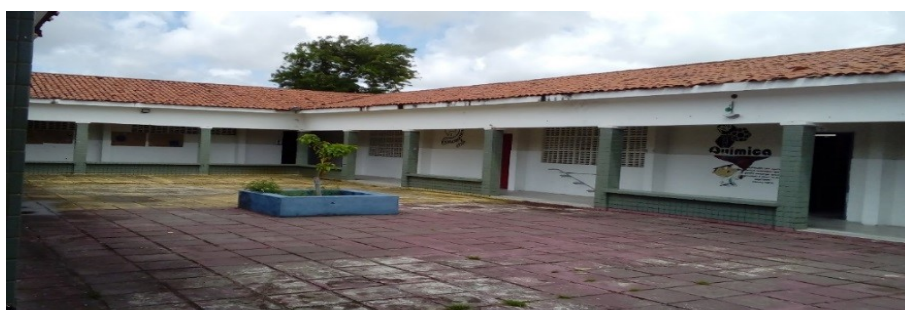
Figura 2: Vista do pátio interno da escola ECI que separa os blocos de aulas. Fonte: pesquisa de campo. Acervo pessoal da pesquisadora.
