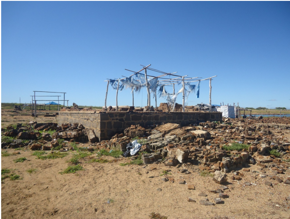
Barraca do pós inundação - construída utilizando uma estrutura que restou de uma das construções da cidade velha. Foto: João Oliveira.
