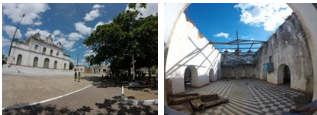
Figura 02. À esquerda, a Igreja do Senhor da Ascensão em Mirandela, construída em 1701 pelo povo Kiriri no centro do aldeamento jesuíta Saco dos Morcegos, e o seu cruzeiro, marco zero do território indígena Kiriri. À direita, o interior da mesma igreja, com o telhado desabado.
