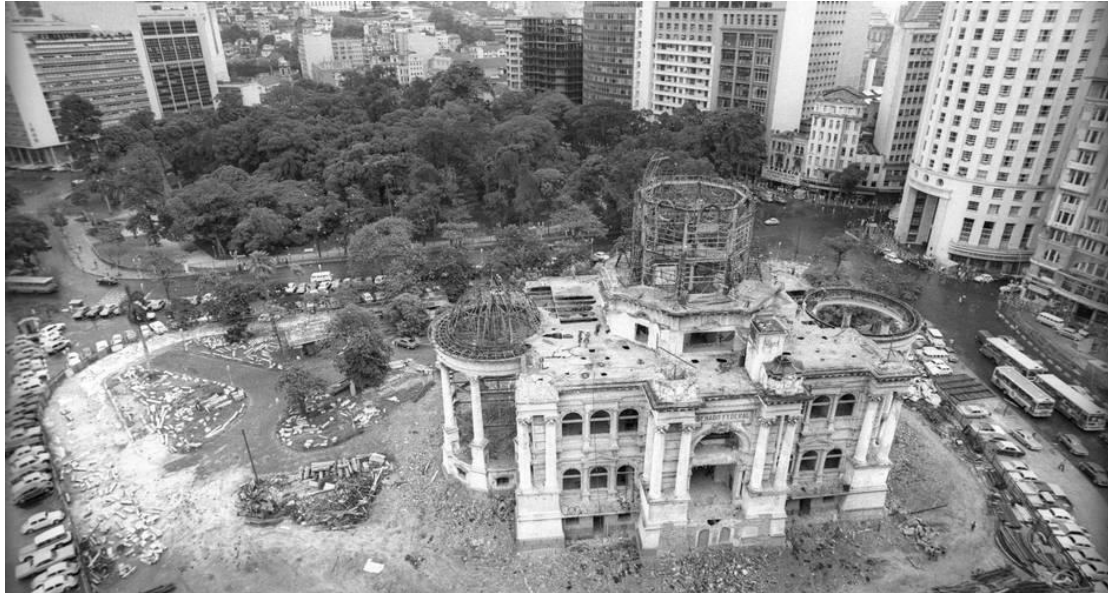
Fig. 2: início da demolição (Alcyr Cavalcanti/Acervo O Globo)
