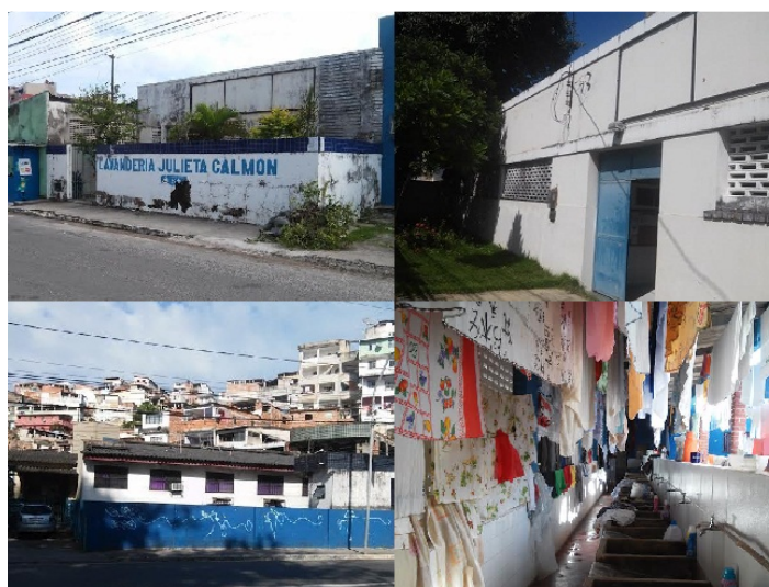
Figura 1 – Lavanderias Comunitárias de Salvador. (Acima: Julieta Calmon – São Gonçalo e abaixo Aristides Novis, vista da fachada e interior) Fotos – Lucian Alcântara (2015).
