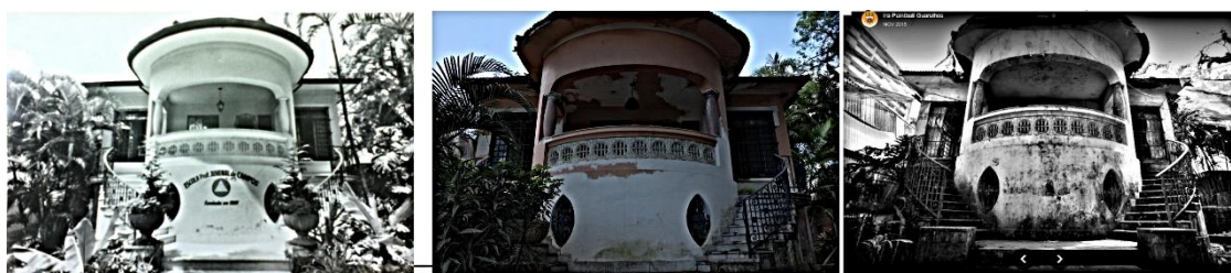
Figura 7: Registro fotográfico em acervos existentes: Campo Casarão-Guarulhos
