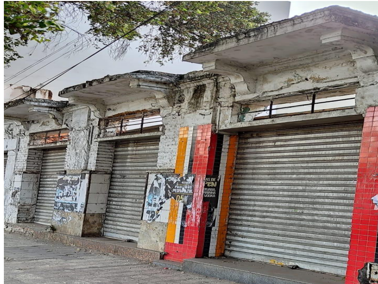
Figura 5: Casa de Otávio Soares demolida no centro de GV
