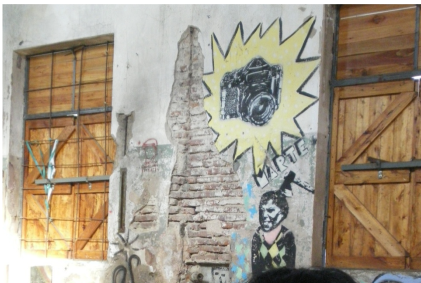
Imagen 2 y 3: Paredes internas del Centro Cultural.
