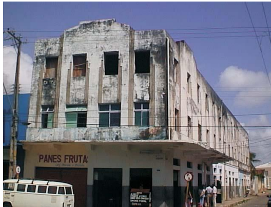
Figura 2- Edifício Paris em Natal. Fonte: Projeto ReHabitatar / Secretaria Municipal de Meio Ambiente e Urbanismo. Natal: SEMURB, 2007.
