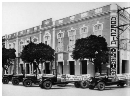
Figura 3- Edifício Tavares de Lira. Fonte: arquivo pessoal da autora.
