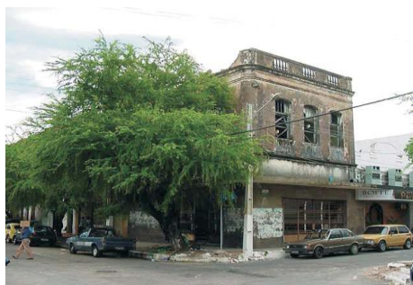
Figura 4- Edifício Tavares de Lira. Fonte: Projeto ReHabitat / Secretaria Municipal de Meio Ambiente e Urbanismo. Natal: SEMURB, 2007.
