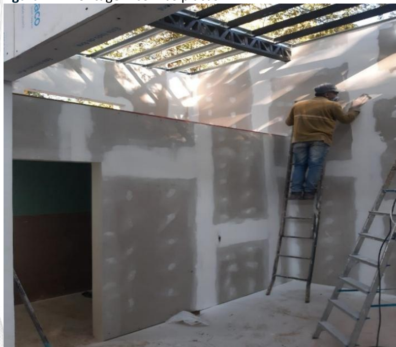
Figura 4 – Montagem com as placas
