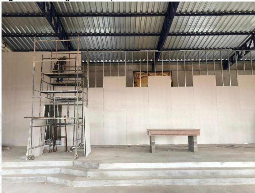
Figura 3 – Montagem com as placas
