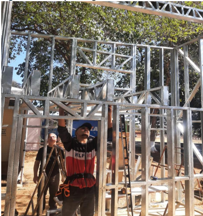
Figura 2 – Instalação das guias metálicas
