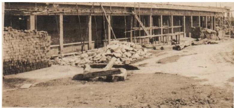
Foto 4 – Construção do prédio do Carlota Barreira: vista frontal
