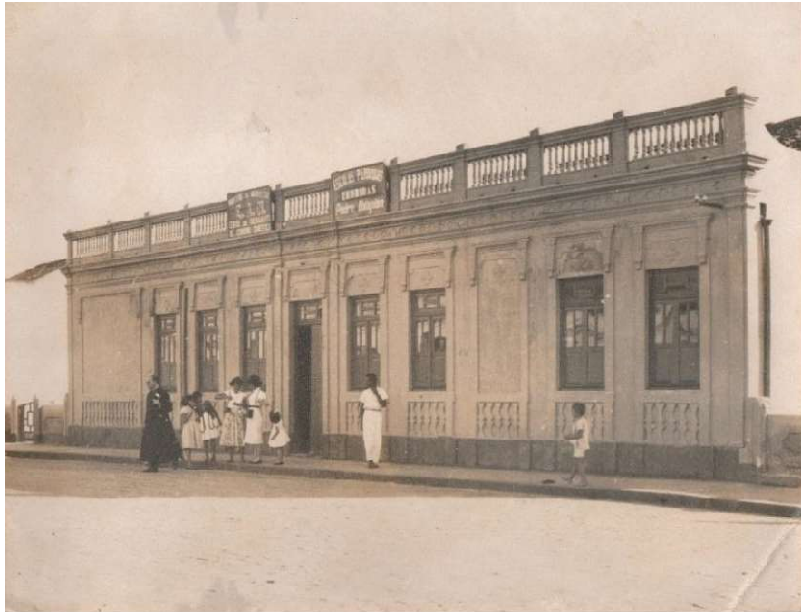
Foto 3 - Prédio Escolas Reunidas Padre Ibiapina (1954)
