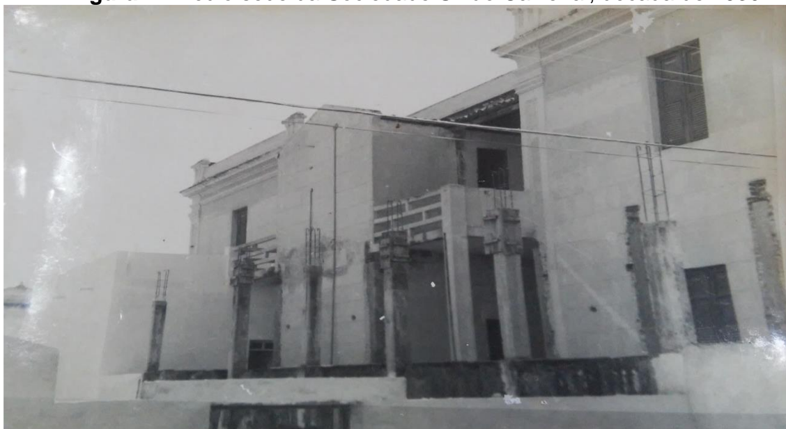
Figura 2: Prédio sede da Sociedade União Caixeiral, década de 1930
