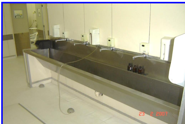
Figura 4 – Lavado do Centro cirúrgico (HUOL-UFRN) – Observa-se o controle de água por célula fotoelétrica e solução degermante por pedal pneumático.
