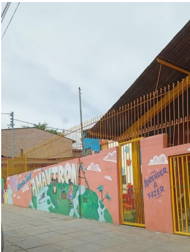
Figura 4 - Fachada da AMAVTRON. Arquivo pessoal.
