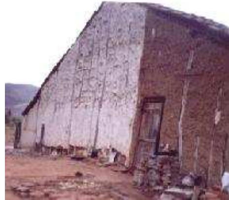
FIGURA 7 - Fachada lateral esquerda da Casa da Fazenda Antonio de Azevêdo
