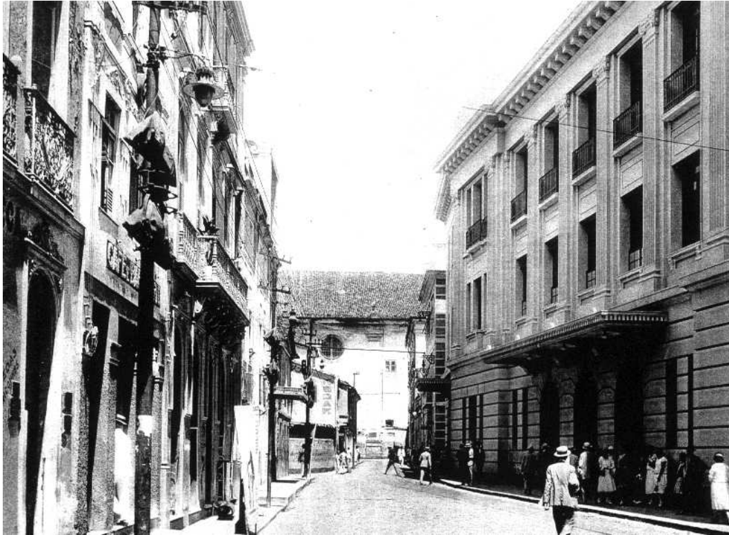
FIGURA 1- 1928. À direita, prédio hoje ocupado por órgão da Prefeitura Municipal de Salvador e Coelba; a esquerda, os dois quarteirões demolidos em 1933 e, ao fundo, a lateral da antiga igreja da Sé (Santos, 1933).
