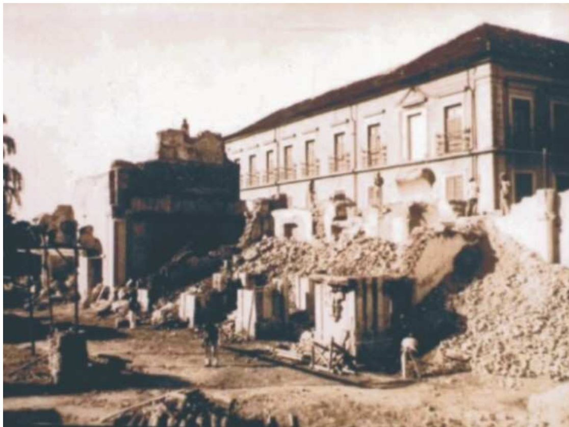
FIGURA 3- 1933. Demolição da antiga igreja da Sé (Santos, 1933).
