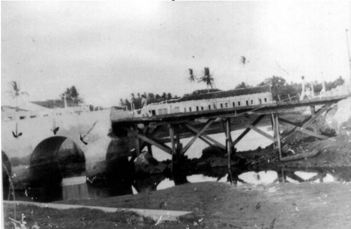
Restos da antiga ponte de Macaíba, destruída em inundaç o do rio Jundi a na d cada de 1950. Ao fundo, os armaz ns constru dos por Fabricio Gomes Pedrosa. Fonte: Acervo Anderson Tavares.
