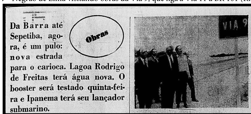
Figura 7 - Negrão de Lima visitando obras da Via 9, que liga a Via 11 à BR 101 (Rio-Santos)
