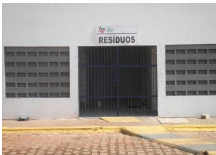
Figura 07 - Local para armazenamento dos resíduos
