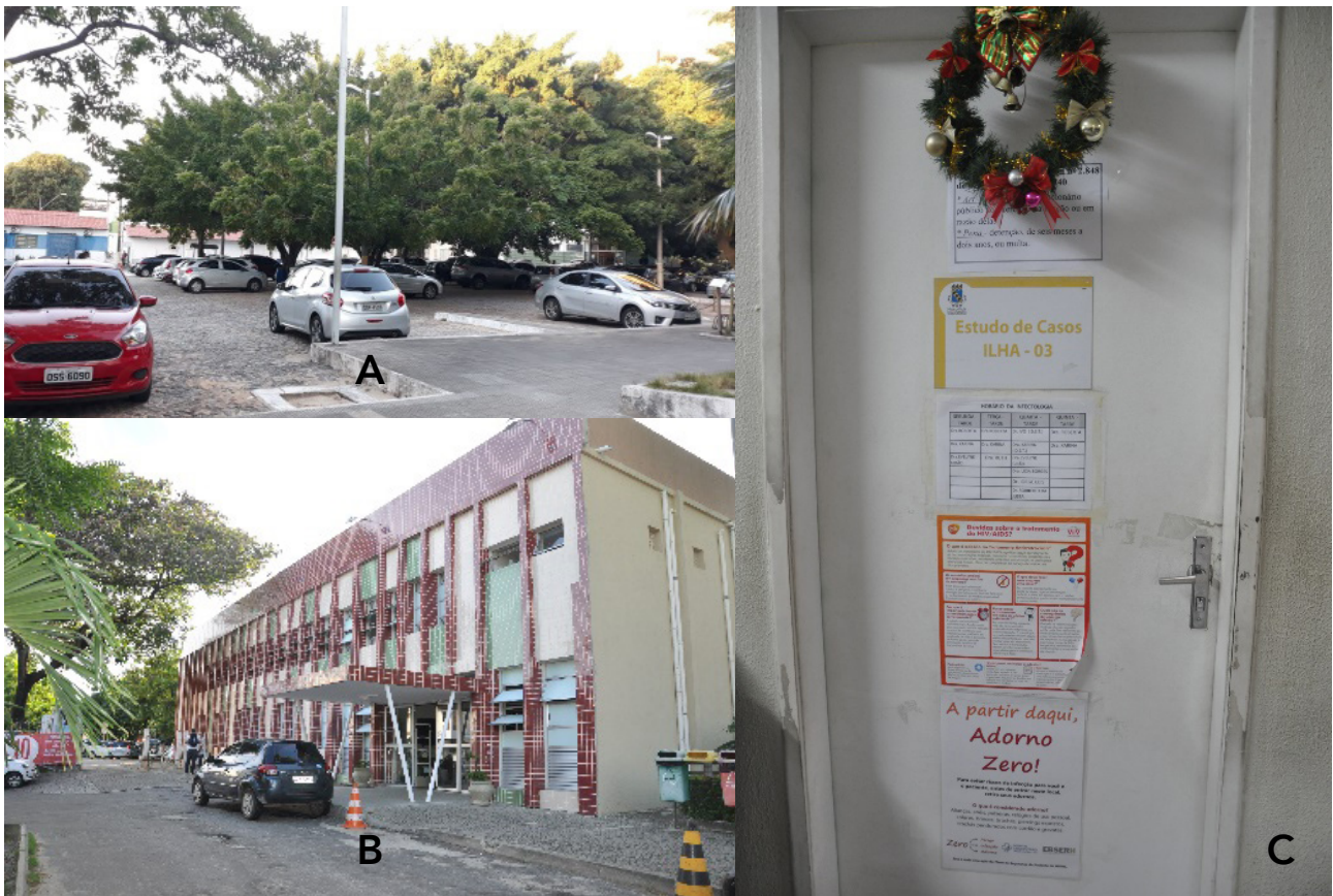
Figura 2 – Problemas de sinalização do HUWC: a) Ausência de totem físico para conectar prédios localizados no entorno do estacionamento da área de exames; b) Fachada do bloco central não identificada; c) Porta de um dos ambulatórios especializados com excesso de mensagens (Unidade de Comunicação Social do HUWC)
