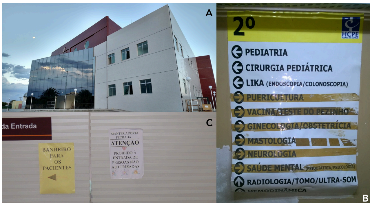
Figura 3 – Problemas de sinalização em hospitais da Rede Ebserh: a) Ausência de identificação de fachada em policlínica da Universidade Federal do Vale do São Francisco; b) Sinalização informal e deficitária em corredor do Hospital das Clínicas de Pernambuco; c) Sinalização informal de acesso restrito e indicação de banheiro para pacientes no Complexo Hospital de Clínicas da Universidade Federal do Paraná
