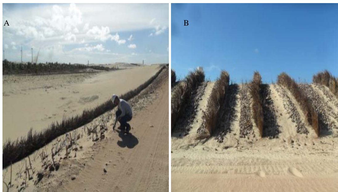
Figura 03 - Principais processos erosivos ocorrentes em parques eólicos na região litorânea, decorrente do fluxo sedimentar eólico das dunas (A) e a atenuado por técnicas de atenuação dos processos erosivos através de palhas e buchas de coco (B). Fonte. O autor.
