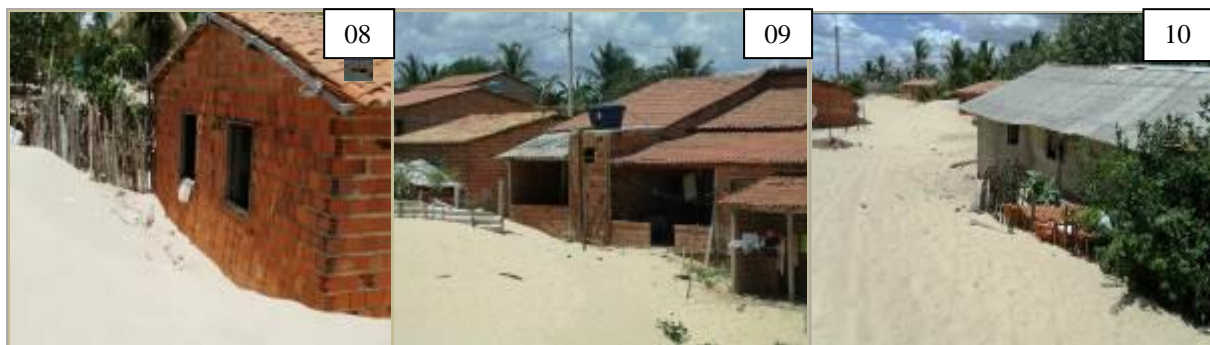
Fotos 08, 09 e 10: Residências inseridas em áreas de dunas móveis. Bairro São José. Fonte: Louzeiro e Feitosa, 2015.
