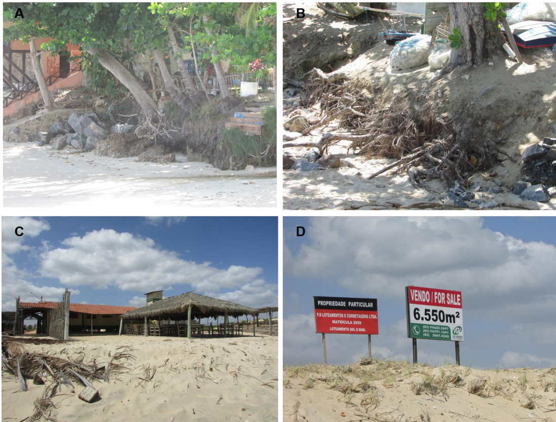
Figura 8. A) Identificação dos impactos ambientais nas praias do Pecém e Taíba (1995 – 2014). Fonte: Portela (2017). Legenda: A; B e C) Especulação imobiliária em zona de berma; e D) Venda de terrenos em áreas de dunas, áreas de preservação por lei.
