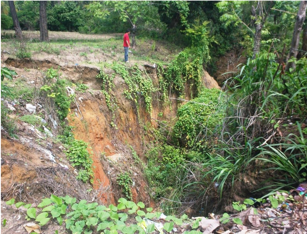
Figura 7: Voçoroca formada na área urbana do Distrito de Livramento.
