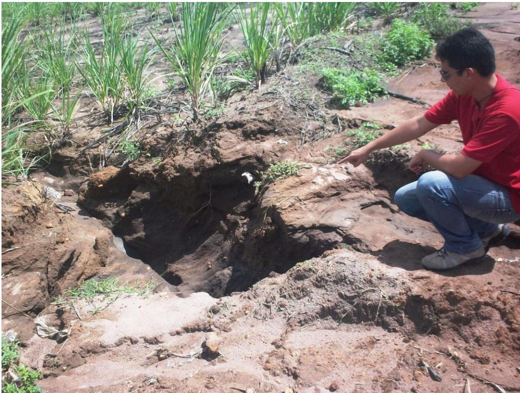
Figura 6: Formação de cicatrizes erosivas na porção somital da vertente em virtude da canalização de fluxos superficiais, resultando em intenso processo erosivo.
