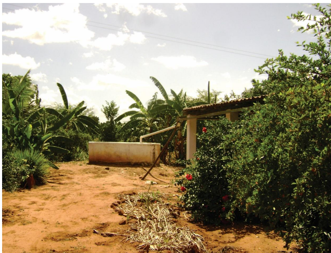
Figura 4: Panorama da cisterna de placas com capacidade de armazenamento de 16.000 L de água. Foto: RODRIGUES, 2018.
