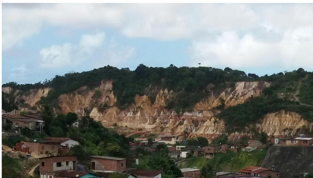
Figura 3. Tabuleiros dissecados no bairro dos Estados. Destaque para presença de processos erosivos. Fonte: registrado pelos autores
