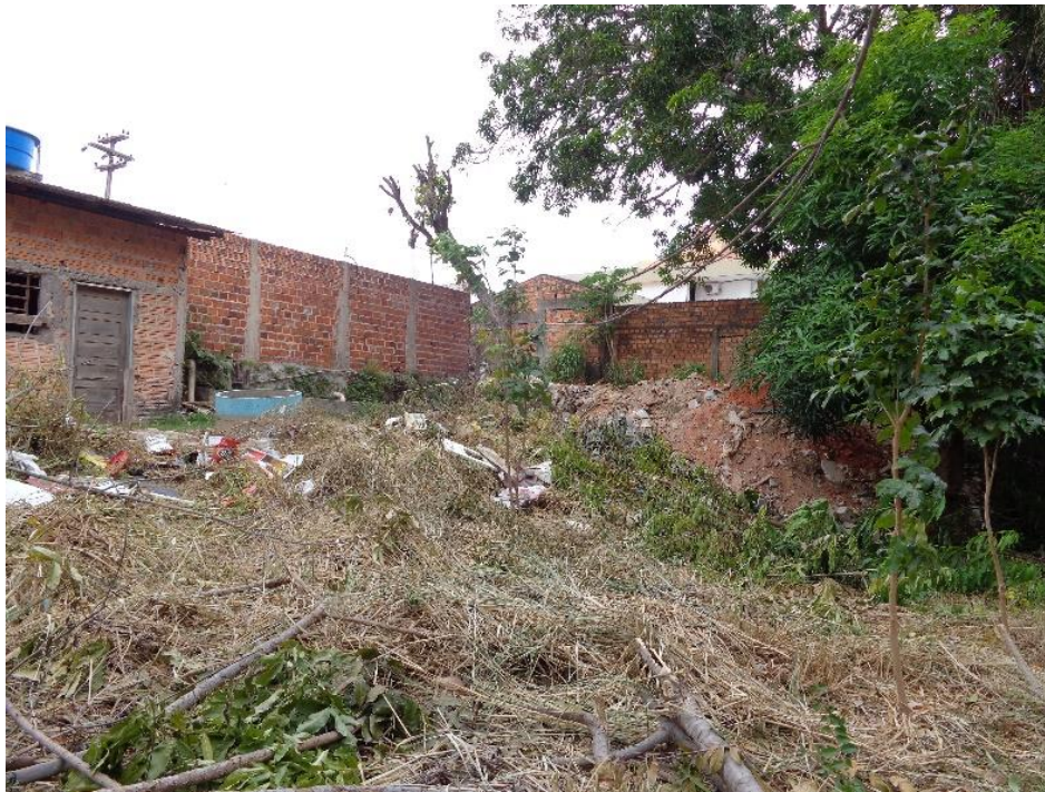
Figura 5: Construção de casas na APP e deposição de lixo no Urucutiua. Fonte: Autores, 2018.
