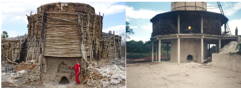
Figura 03: Vista geral de uma caieira e um forno de cal vertical para calcinação do calcário, respectivamente, nas localidades de Aroeiras e Vila Basílio (Coreaú). Fonte: Nataniel Albuquerque (2014; 2003).
