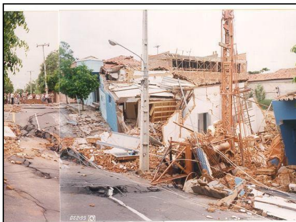
Figura 3 - evento de colapso do solo no município de Teresina/PI ocorrido no ano de 1999. Fonte: Pimentel (2008).
