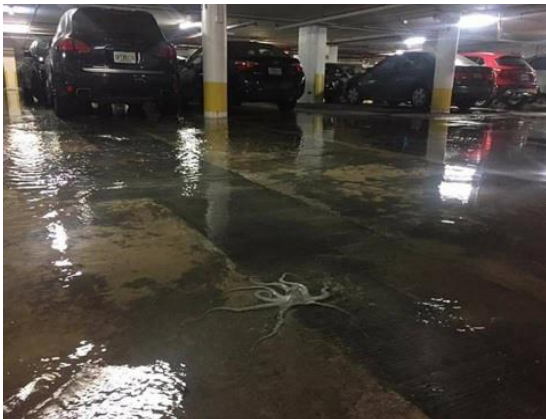
Figura 5 - Presença de fauna marinha em estacionamentos de prédio litorâneos em Miami. Fonte: Richard Conlin, publicado no jornal Miami Herald em 14 de novembro de 2013.
