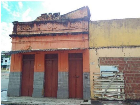
Figura 5 – Casa – Comércio das 7 Portas. Fonte: autor, (2019).
