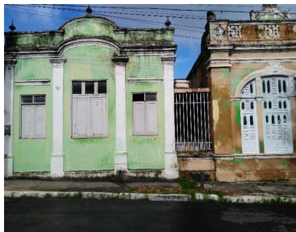
Figura 2 - Estilos de residências com fachadas sem modificações na rua Correia de Oliveira, União dos Palmares. Fonte: autor, (2019).
