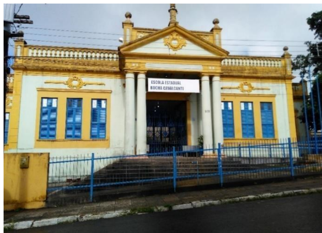
Figura 1 - Escola Estadual Rocha Cavalcanti de estilo neoclássico. Fonte: autor (2019).
