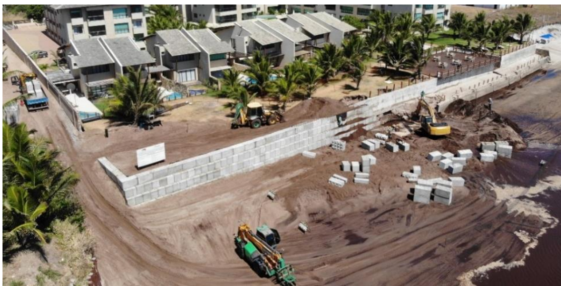
Figura 12 – Execução da contenção marítima / Ipojuca -PE Fonte: Autores (2019).
