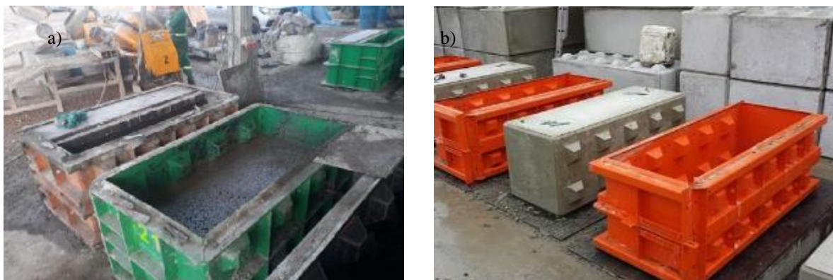
Figura 11 – Modelagem e concretagem dos blocos a) concretagem b) desforma do bloco de concreto Fonte: Autores (2019).
