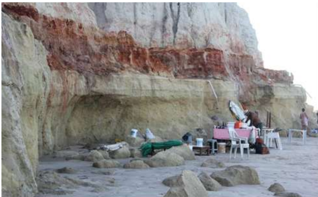
Figura 6 – Comerciantes ambulantes localizados próximos às estruturas das falésias.
