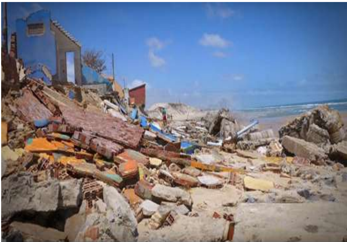
Figura 7 – Escombros à beira mar de estruturas comerciais na praia de Morro Branco destruídas pelo mar. Fonte: Eduard Sweets, 2016.
