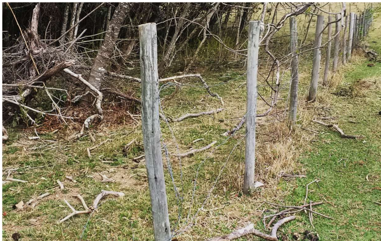
Figura 9 – Cercamento em estado precário (ver arames arrebitados) na nascente 8. Fonte: Elaborado pelos autores (2022).
