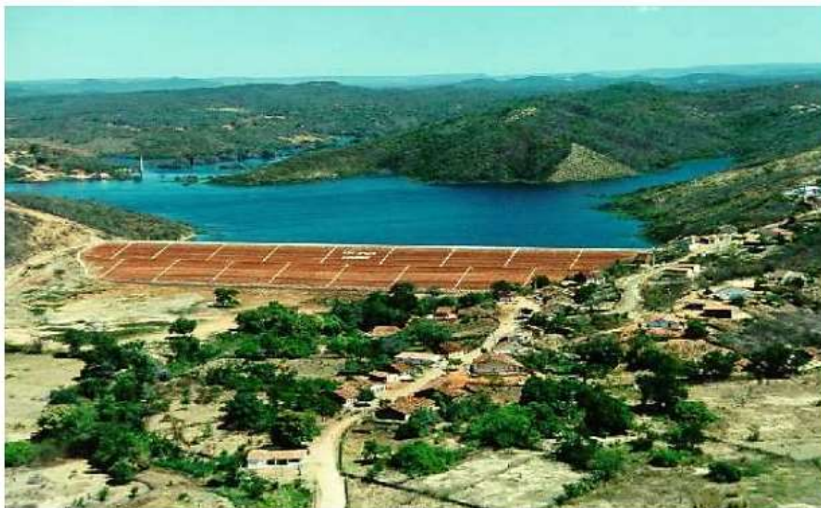
Figura 2 – Vista geral da barragem.
