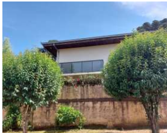
Figura 8 – Casa de alvenaria com dois pisos. Foto: Fabiula Eurich Machado (2023).
