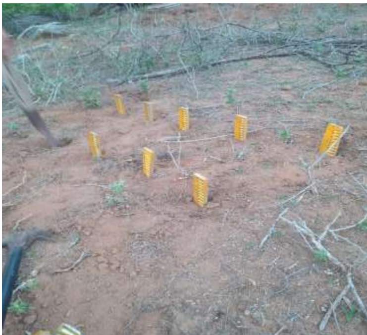
Figura 4 – Pinos em processo de instalação na estação 01. Fonte: Dados da pesquisa (2022).
