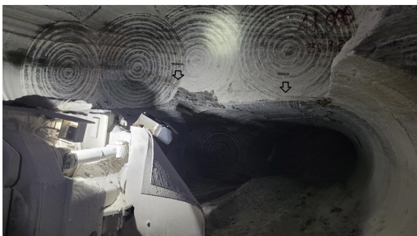
Figura 5 – Análise de campo evidenciando abertura de trinca do teto escavado Fonte: Autores (2023).
