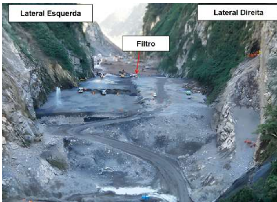
Figura 7 – Vale encaixado na Região de Apoio da Barragem Fonte: Intertechne (2016).
