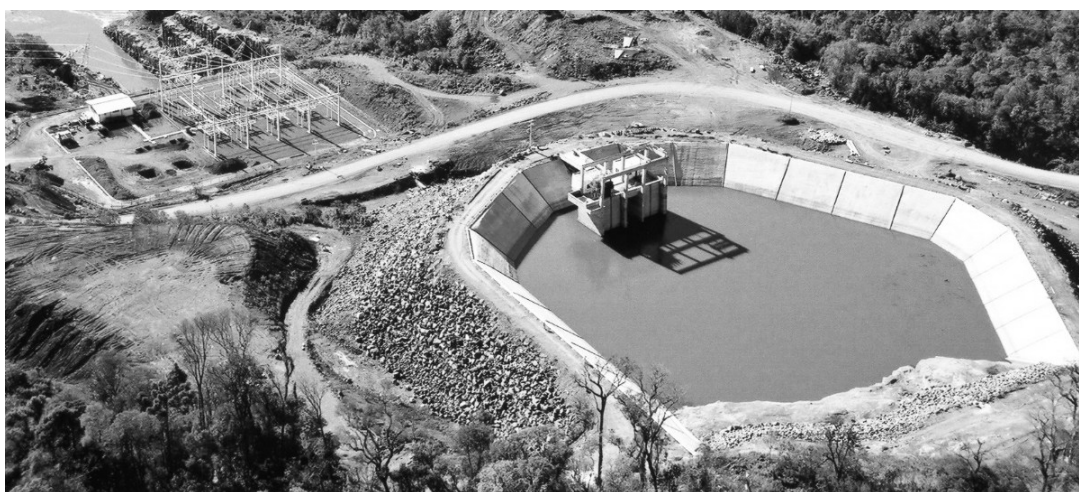
Figura 19 – Dique da Câmara de Carga da UHE Santa Clara.
