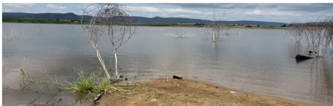
Figura 3 – Açude Realejo, localizado no município de Crateús/CE, foto de março/2022. Fonte: Autores (2022).
