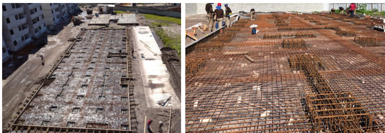
(a) (b) Figura 2 – (a) Locação e (b) Armação do radier estaqueado. Fonte: Silva Júnior (2021).
