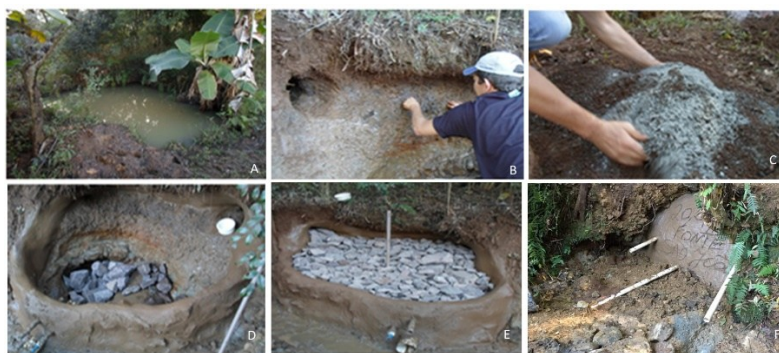
Figura 1 – Recuperação da nascente através do método solo-cimento. A) Nascente a ser recuperada. B) Limpeza da nascente. C) Mistura de solo e cimento. D) Construção da mini barragem. E) Nascente sendo coberta por fragmentos de rocha. F) Nascente recuperada e em funcionamento.
