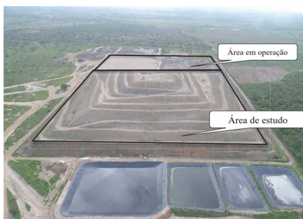
Figura 3 – Célula do aterro após junção das C1, C2, C3 e C4.
