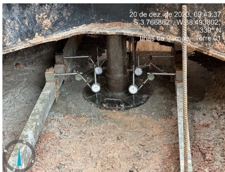
Figura 2 – A placa circular metálica usada no ensaio de carga.
