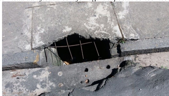
Figura 4 – Tapa de Poço de Visita danificada com ferragem exposta: sérios riscos para pedestres ou ciclistas.
