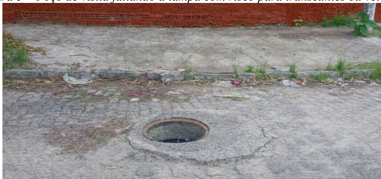
Figura 5 – Poço de visita faltando a tampa com risco para transeuntes ou veículos.
