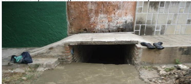
Figura 1 – Boca de lobo tipo ralo de guia com abertura excessiva produzindo situação de risco.
