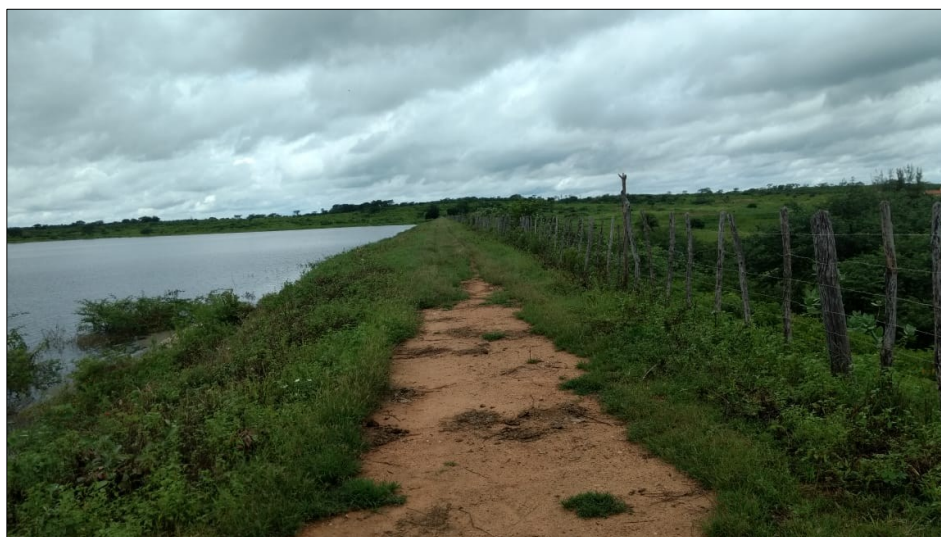
Figura 4 - Barragem do Açude São Francisco, Crateús - CE Fonte: Autores (2026).
