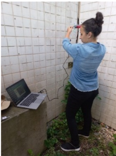
Figura 2 – Digitalização da fissura por luz estruturada. Fonte: Os autores (2026).
